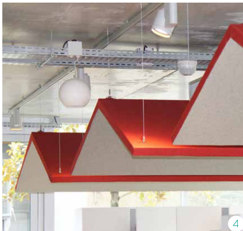
2 TEMPO Panneaux 1210 x 1210 x 50 avec réservation pour luminaire, «LA» Maille 3D Rouge 31 Fixation : Suspendus par 4 câbles
